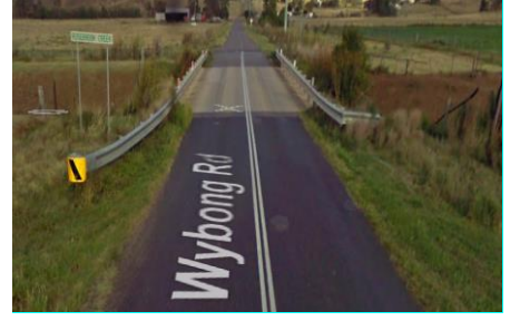
3. Wybong Road (Rosebrook Bridge)
